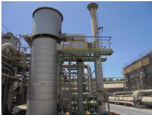
รูปที่ 2 ปล่องระบายของหม้อต้มน้ำมัน (HTM)
